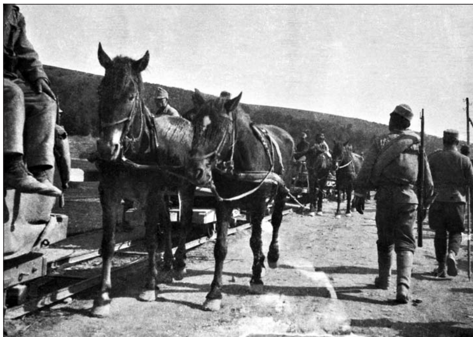
27. Stavba polní dráhy u Varama v Karpatech (květen 1915).
