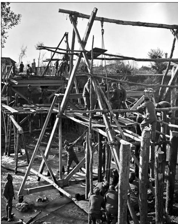
16. Stavba mostu přes říčku Monticano u Lutrana v Itálii (15. listopad 1917).
